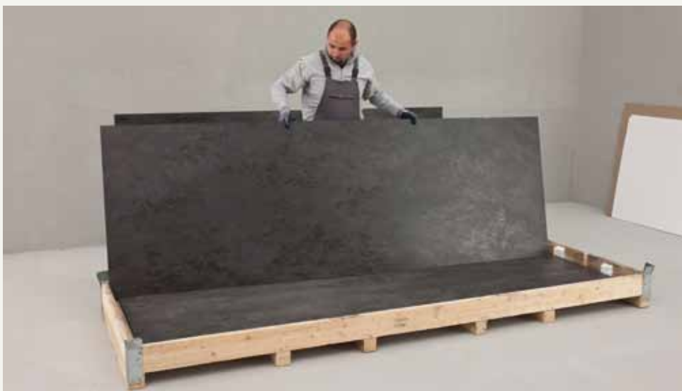
fig.5 / Положите упаковку возле подлежащей облицовке поверхности. Поднимите плиту в вертикальное положение, держась за ее длинную сторону.
