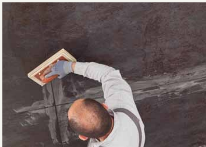
fig.39 / Затирка швов.
