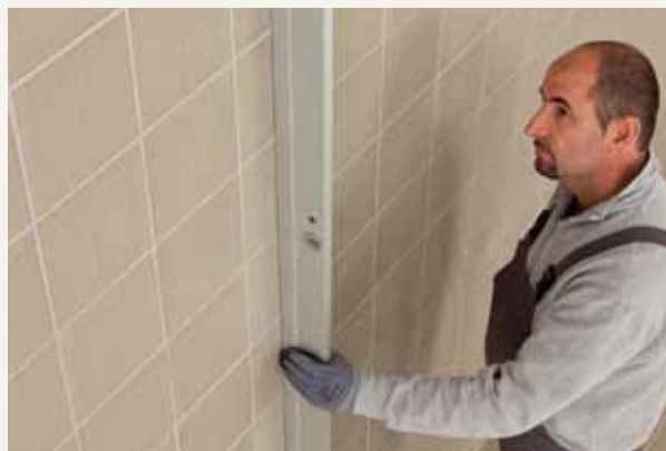
fig.34 /Проверьте ровность облицовываемой стены
