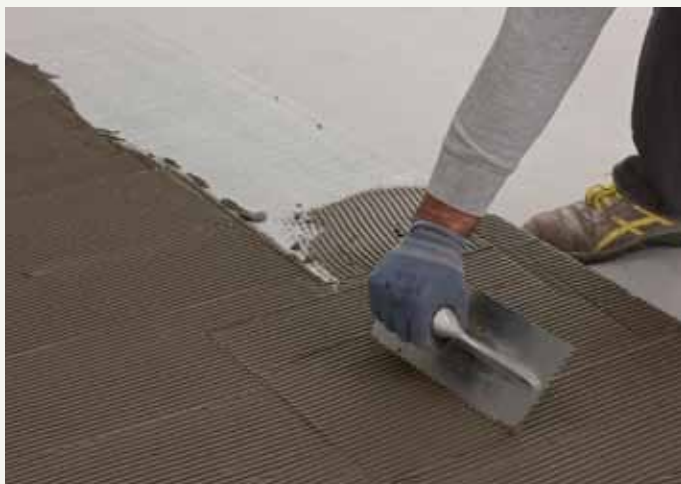
fig.36 / Нанесение клея на тыльную сторону плитки.
