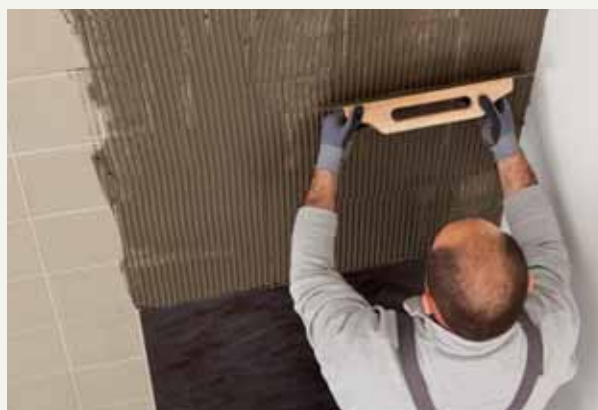
fig.35 /Нанесение клея на стену
